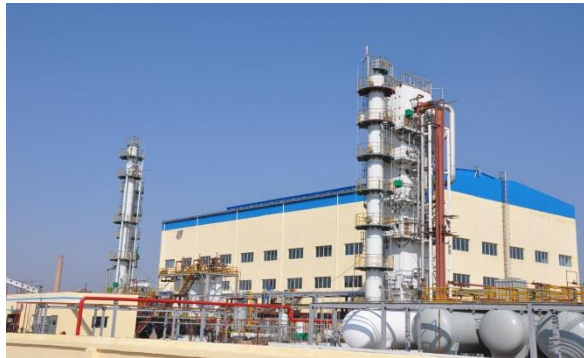
600,000Nm 3 /day LNG Plant in Erdos
